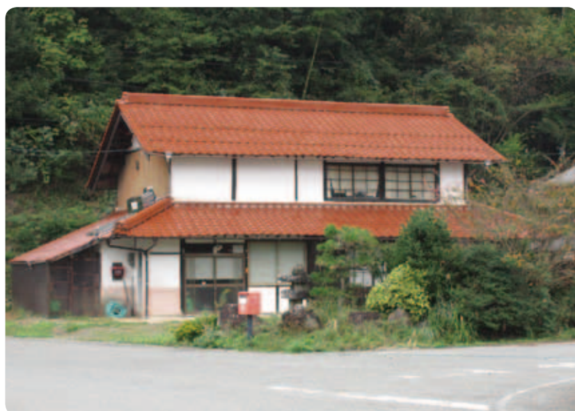
改修中のお試し住宅（草木地区）
