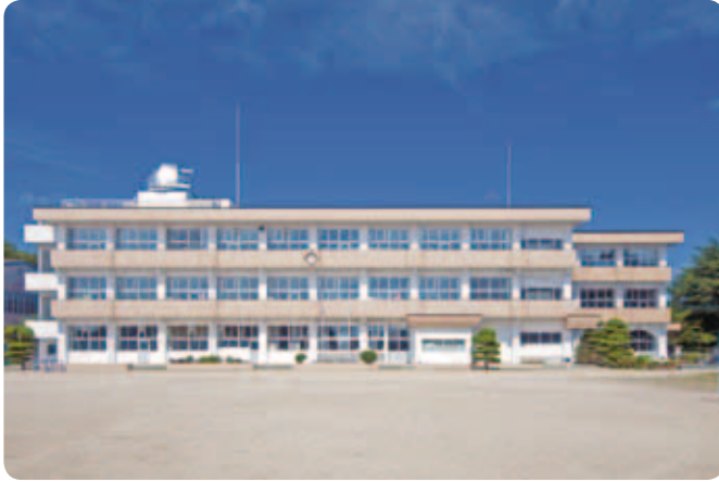
大規模改修工事を終えた来見小学校
