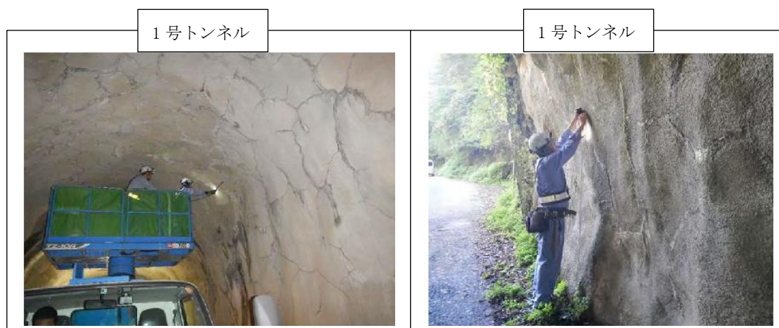
図 1-3 トンネル定期点検状況（平成 30 年度）
