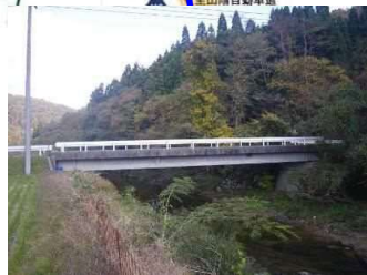
昭十橋 L=22.4m(PC橋) 1983年架設
