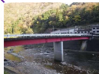
仁滝橋 L=54.5m(鋼橋) 1986年架設
