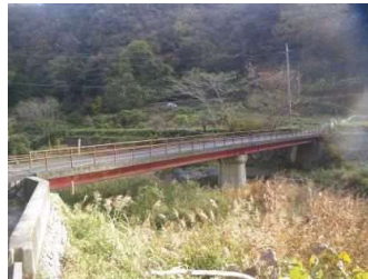
日南原橋 L=29.0m(鋼橋) 1960年架設
