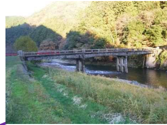
小野橋 L=42.6m(RC橋) 1953年架設
