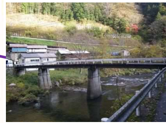
手入橋 L=56.4m(鋼橋) 1973年架設
