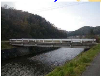
妙見橋 L=21.0m(PC橋) 1991年架設
