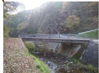
小田橋 L=17.4m(PC橋) 1989年架設
