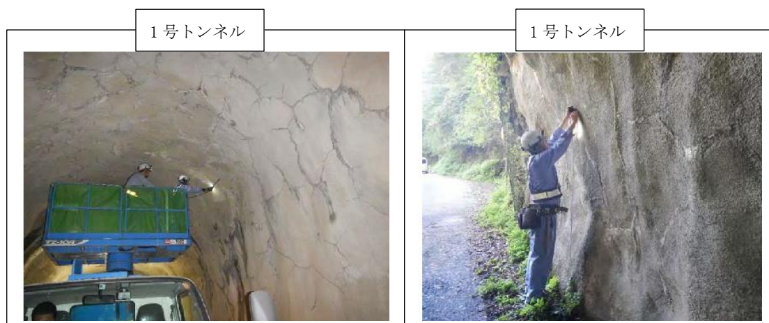
図 1-3 トンネル定期点検状況（平成 30 年度）
