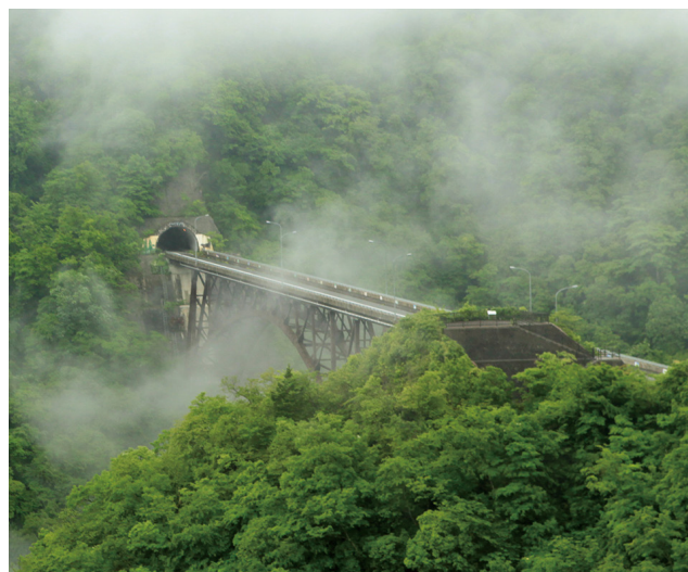
耐震改修工事を行う広域農道福枳川大橋
