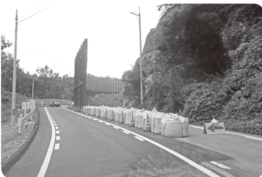
復旧中の国道182号
