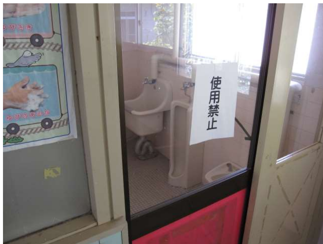
保育室 3 横 子供用トイレ
